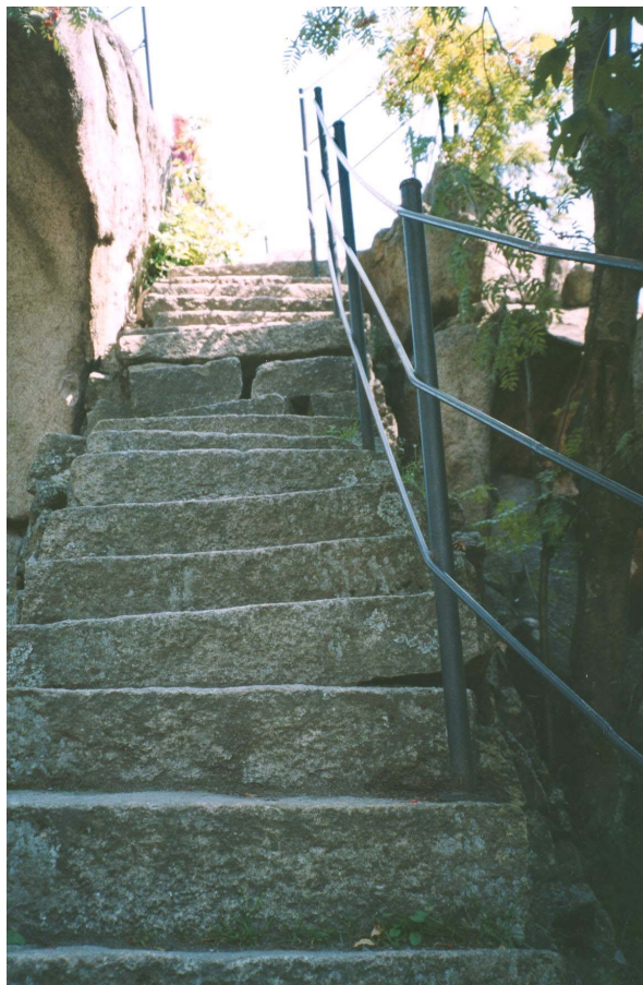
Detail kamenného schodiště
