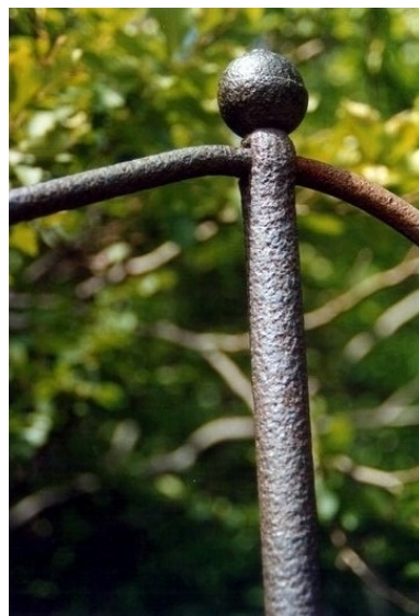
Detail kovaného zábradlí
