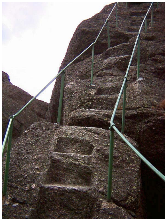
Detail vytesaného schodiště
