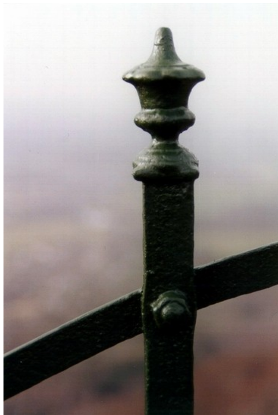
Detail ozdobné kované hlavice zábradlí
