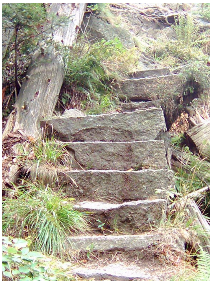
Detail kamenného schodiště
