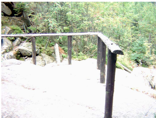
Detail dřevěného zábradlí
