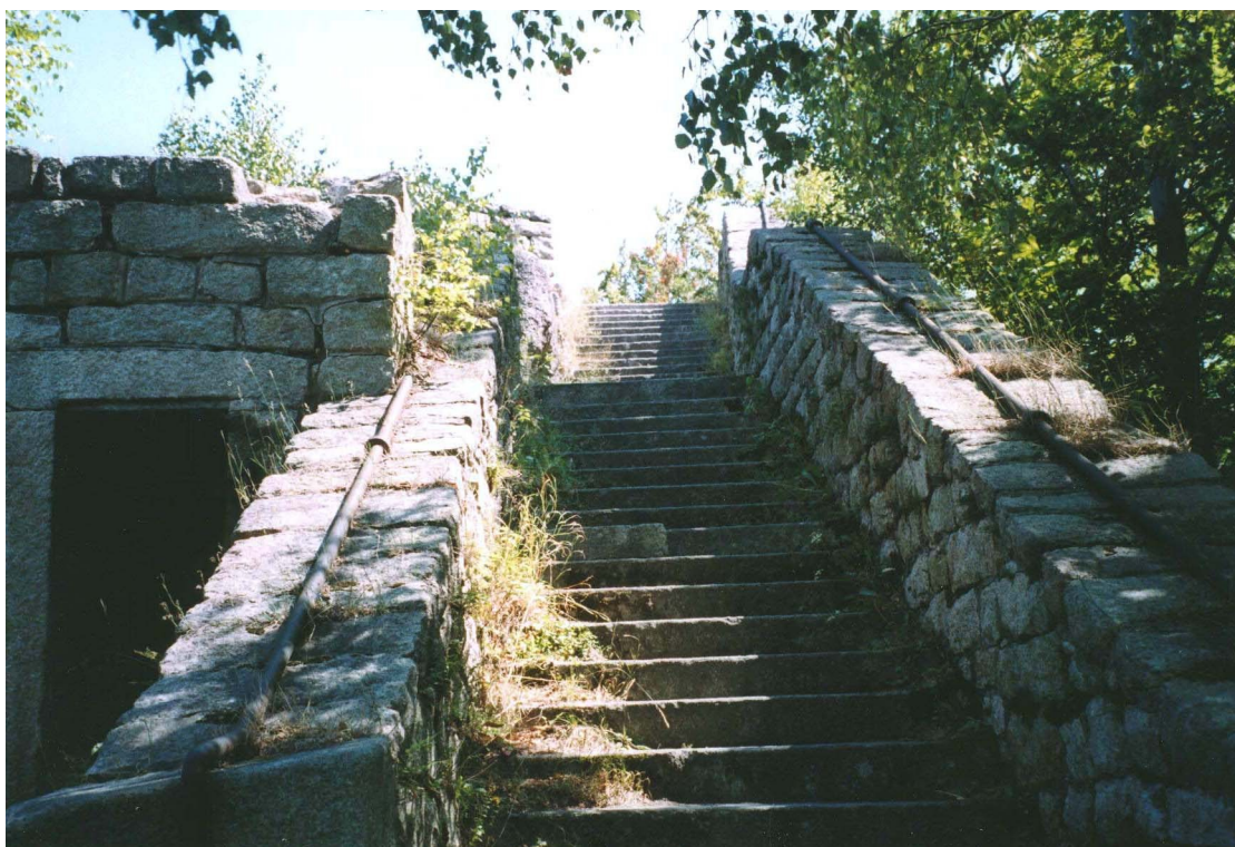
Přístupové kamenné schodiště
